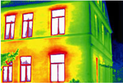
Fig. 1 : Image thermographique d'une maison. Les secteurs rouges indiquent une déperdition d'énergie élevée.
